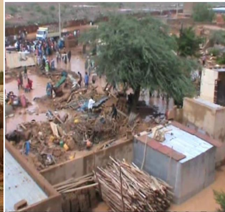
Image 4 : Maison inondées et effondrées dans la ville de Tahoua.
